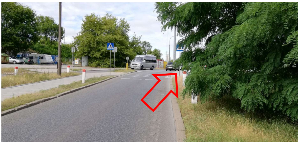
ZDJĘCIE 53 GAŁĘZIE DRZEW OGRANICZAJĄCE WIDOCZNOŚĆ
