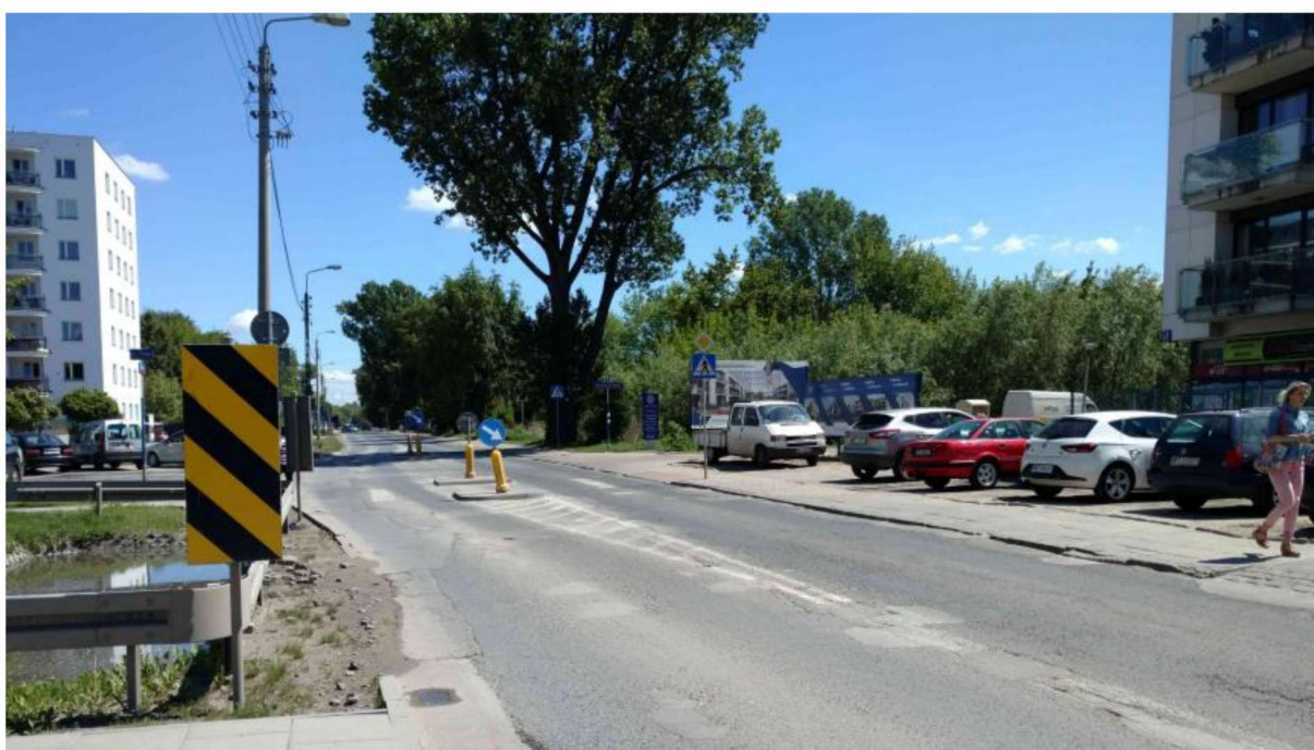
ZDJĘCIE 131 DUBLUJĄCE SIĘ PRZEJŚCIA DLA PIESZYCH
