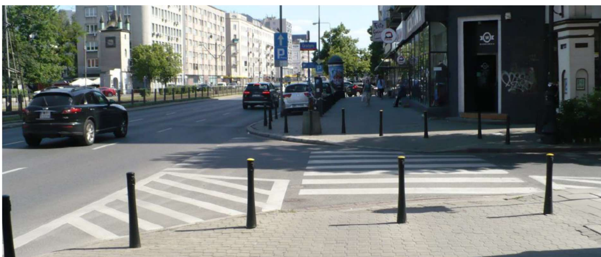
ZDJĘCIE 50 ZAGROŻENIA WYNIKAJĄCE Z GEOMETRII WLOTÓW JEZDNI
