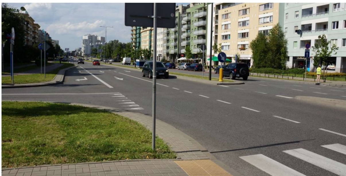
ZDJĘCIE 21 PRZEJŚCIE DLA PIESZYCH W OBSZARZE ZAGROŻENIA WYSOKĄ LUB BARDZO WYSOKĄ PRĘDKOŚCIĄ, WYZNACZONE PRZEZ DWA PASY RUCHU W JEDNYM KIERUNKU
