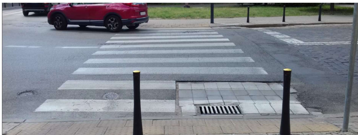
ZDJĘCIE 31 KRATKA ŚCIEKOWA NA PRZEJŚCIU DLA PIESZYCH
