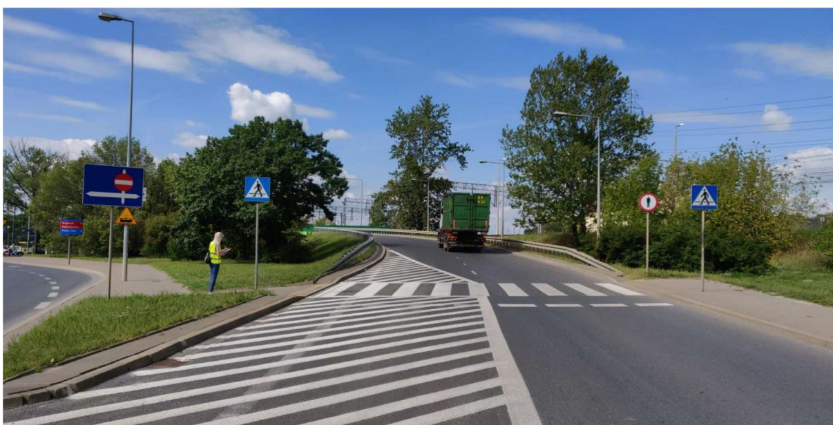
ZDJĘCIE 119 PRZEJŚCIE DLA PIESZYCH SKRÓCONE POPRZEZ POWIERZCHNIĘ WYŁĄCZONĄ Z RUCHU
