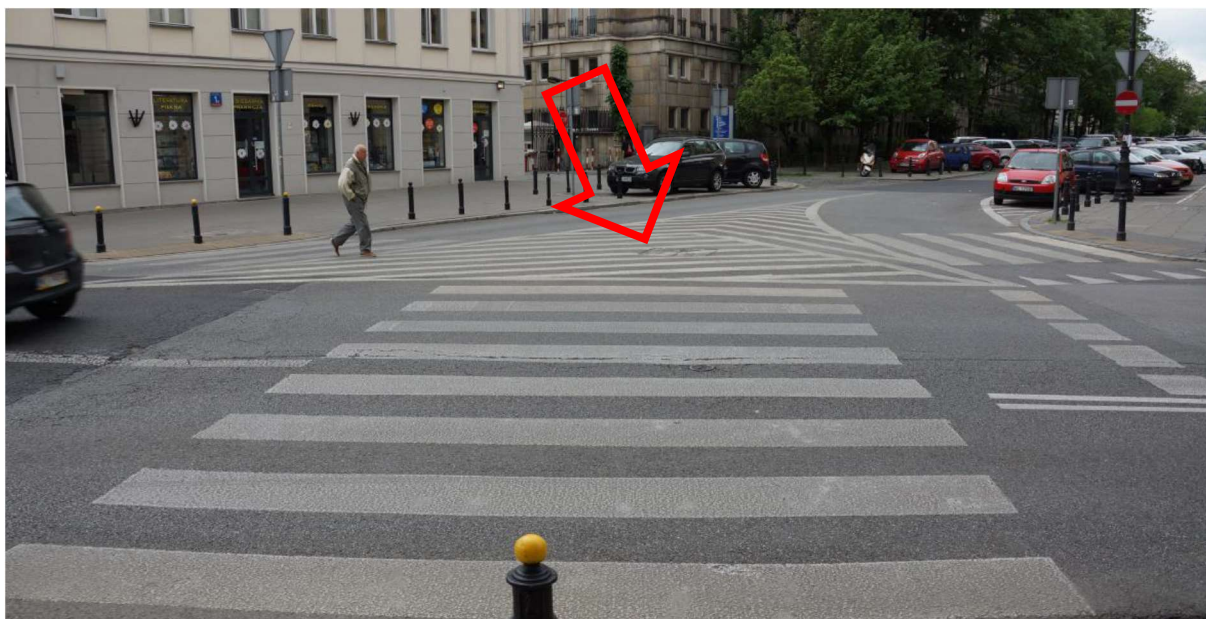
ZDJĘCIE 70 PRZEJŚCIA DLA PIESZYCH PROWADZONE Z TRZECH KIERUNKÓW Z WYSPĄ TRÓJKĄTNĄ OTOCZONĄ LINIĄ P-21, KTÓRA NIE ZABEZPIECZA PIESZEGO
