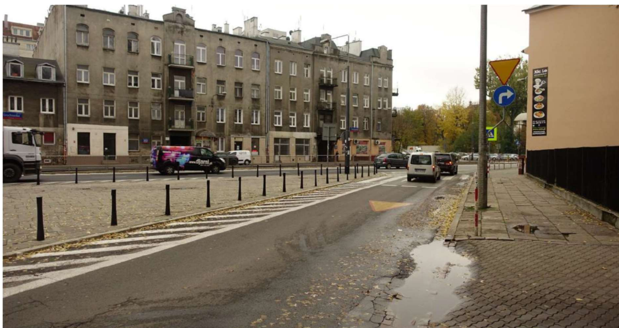
ZDJĘCIE 48 ZAGROŻENIA WYNIKAJĄCE Z GEOMETRII WLOTÓW JEZDNI.
