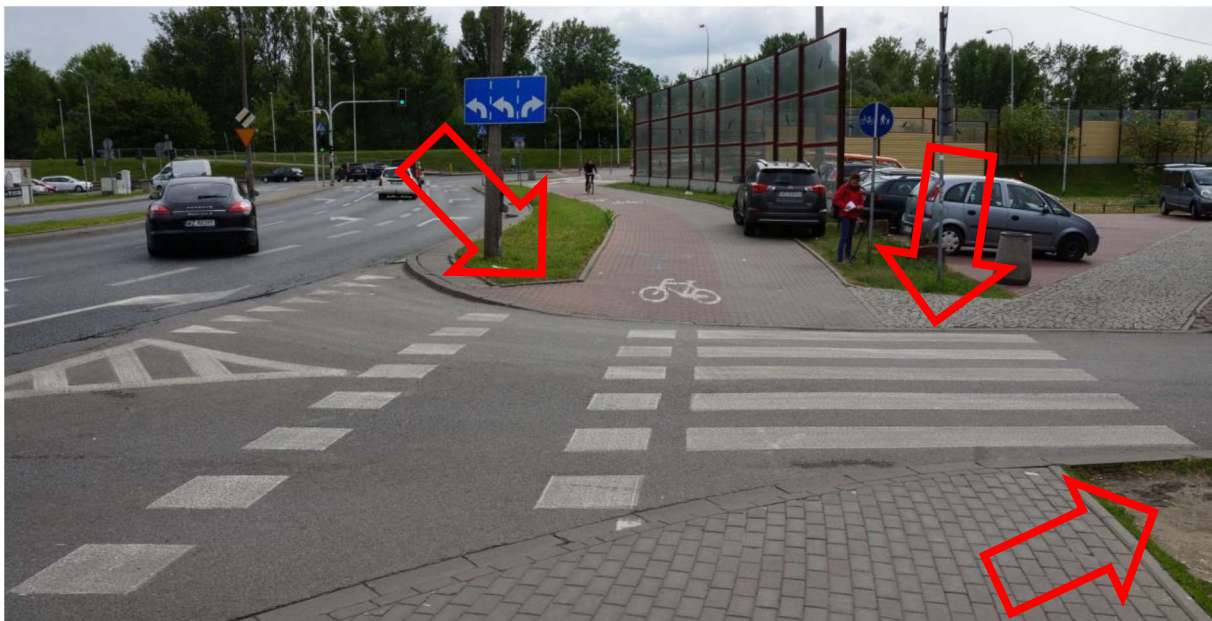
ZDJĘCIE 102 WYDEPTANY TRAWNIK ŚWIADCZĄCY O BRAKU MOŻLIWOŚCI OPUSZCZENIA PRZEJŚCIA DLA PIESZYCH, NIEKONSEKWENTNY UKŁAD CHODNIKA I DROGI ROWEROWEJ
