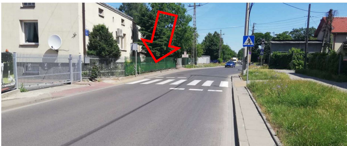
ZDJĘCIE 108 BRAK CHODNIKA PO JEDNEJ STRONIE PRZEJŚCIA. PIESZY JEST ZMUSZONY DO KORZYSTANIA Z JEZDNI
