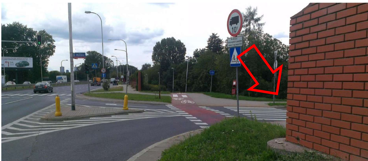
ZDJĘCIE 90 MUR OGRANICZA WIDOCZNOŚĆ. KIEROWCA SKRĘCAJĄCY W PRAWO NIE WIDZI, GDY PIESZY /ROWERZYSTA POJAWIAJĄ SIĘ NA PRZEJŚCIU/PRZEJEŹDZIE
