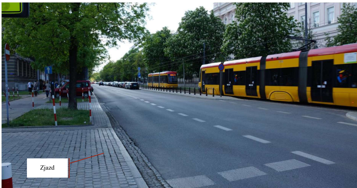
ZDJĘCIE 126 ZJAZD W SĄSIĘDZTWIE PRZEJŚCIA DLA PIESZYCH
