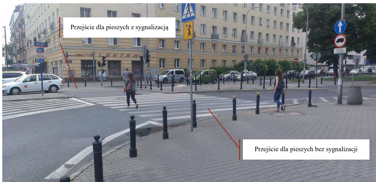
ZDJĘCIE 129 NIEKONSEKWENCJA ORGANIZACJI RUCHU DWÓCH PRZEJŚĆ DLA PIESZYCH POWODUJĄCA DEZORIENTACJĘ UCZESTNIKÓW RUCHU DROGOWEGO
