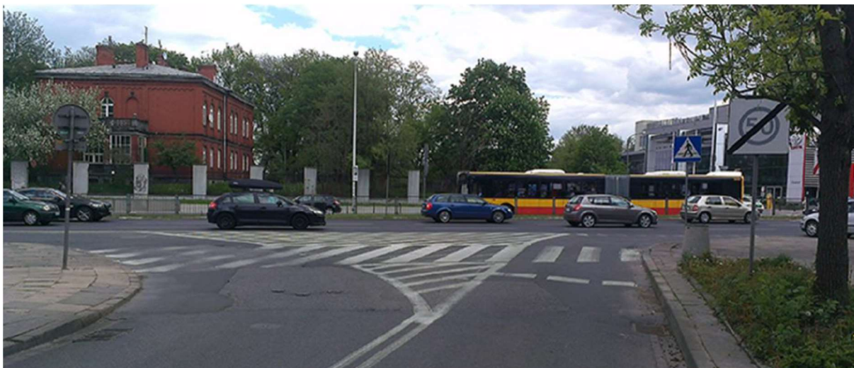
ZDJĘCIE 117 WYSPA TRÓJKĄTNA WYZNACZONA PRZEZ POWIERZCHNIĘ WYŁĄCZONĄ Z RUCHU
