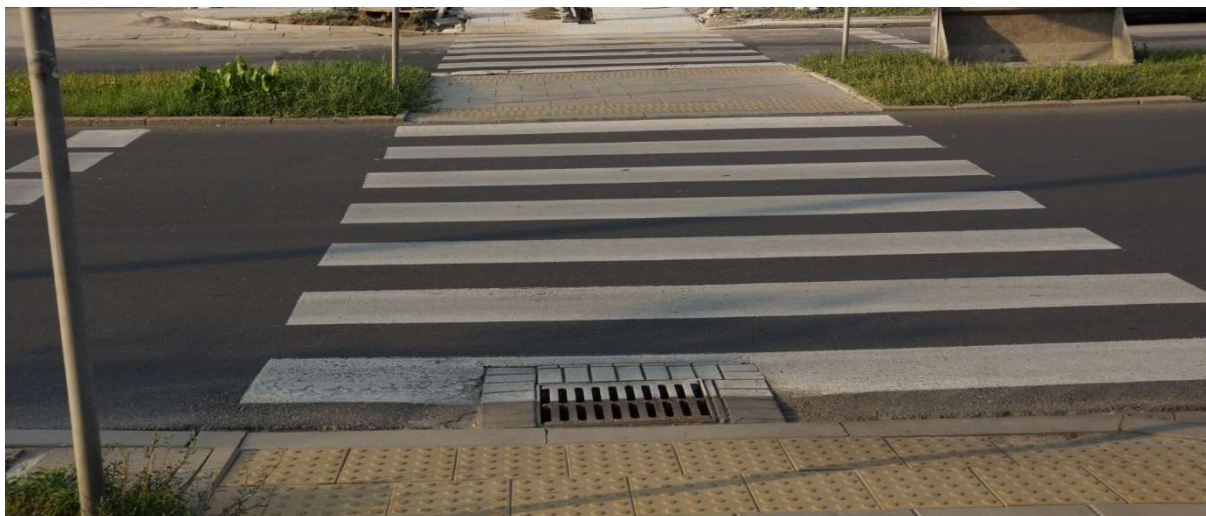
ZDJĘCIE 30 KRATKA ŚCIEKOWA NA PRZEJŚCIU DLA PIESZYCH
