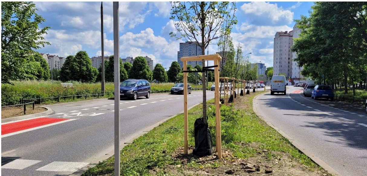
ZDJĘCIE 59 SZPALER DRZEW W PASIE DZIELĄCYM OGRANICZA WIDOCZNOŚĆ PIESZY-KIEROWCA I SKRACA ODLEGŁOŚĆ WIDOCZNOŚCI NA ZATRZYMANIE PRZED PRZEJŚCIEM DLA PIESZYCH
