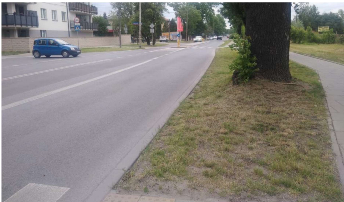
ZDJĘCIE 130 DUBLUJĄCE SIĘ PRZEJŚCIA DLA PIESZYCH
