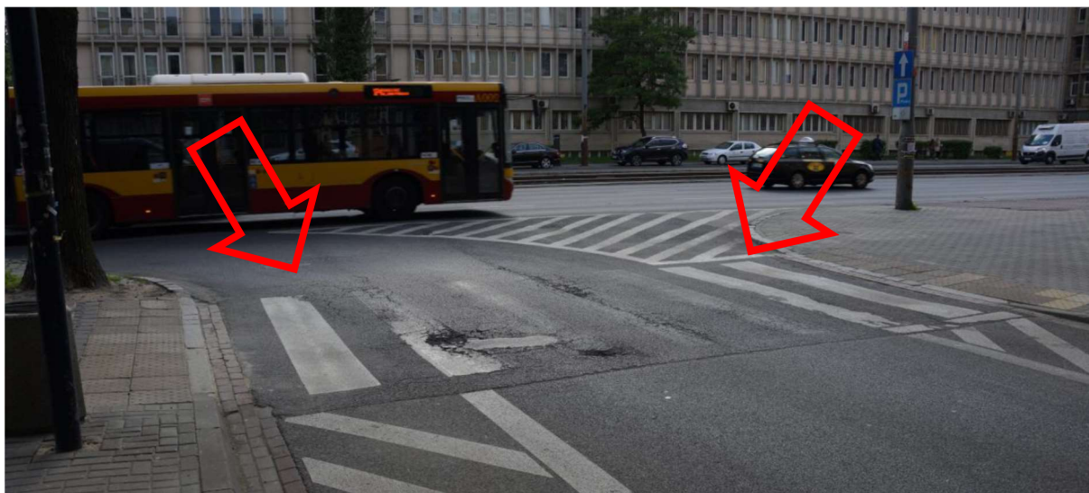
ZDJĘCIE 65 POWIERZCHNIA WYŁĄCZONA Z RUCHU OZNAKOWANA LINIĄ P-21 NIEZABEZPIECZAJĄCA PIESZYCH NA KRAWĘDZI PRZEJŚCIA
