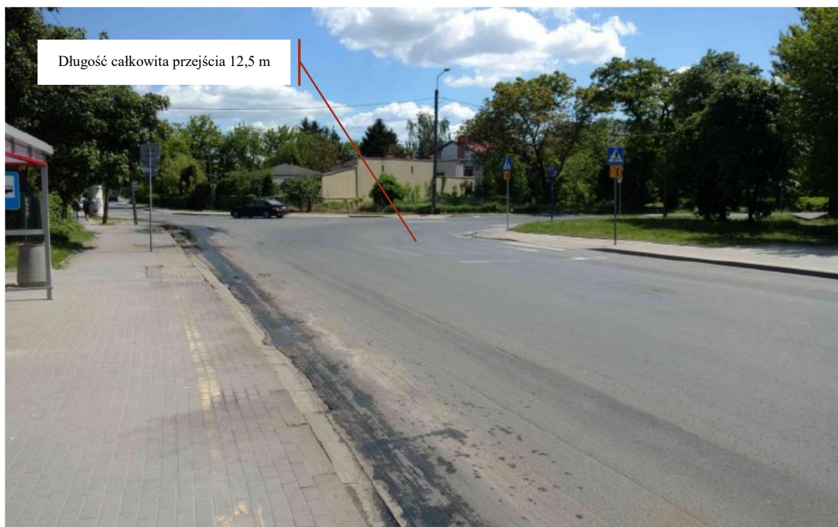
ZDJĘCIE 52 ZAGROŻENIA WYNIKAJĄCE Z GEOMETRII WLOTÓW JEZDNI
