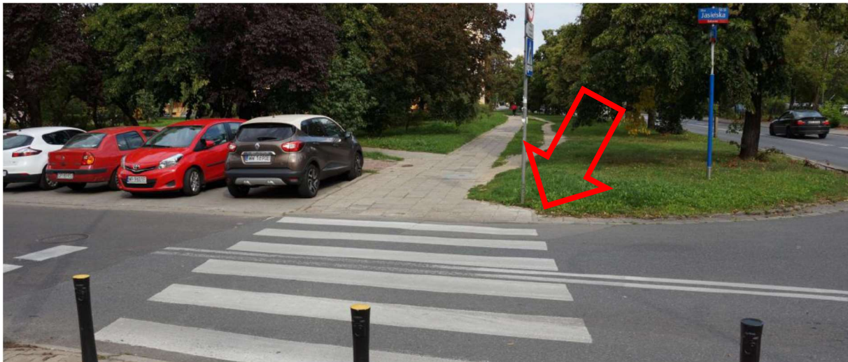
ZDJĘCIE 100 ZBYT MAŁA POWIERZCHNIA NA OPUSZCZENIE PRZEJŚCIA DLA PIESZYCH
