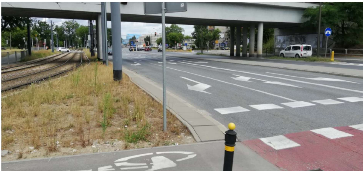
ZDJĘCIE 93 KONSTRUKCJA WIADUKTU OGRANICZA WIDOCZNOŚĆ
