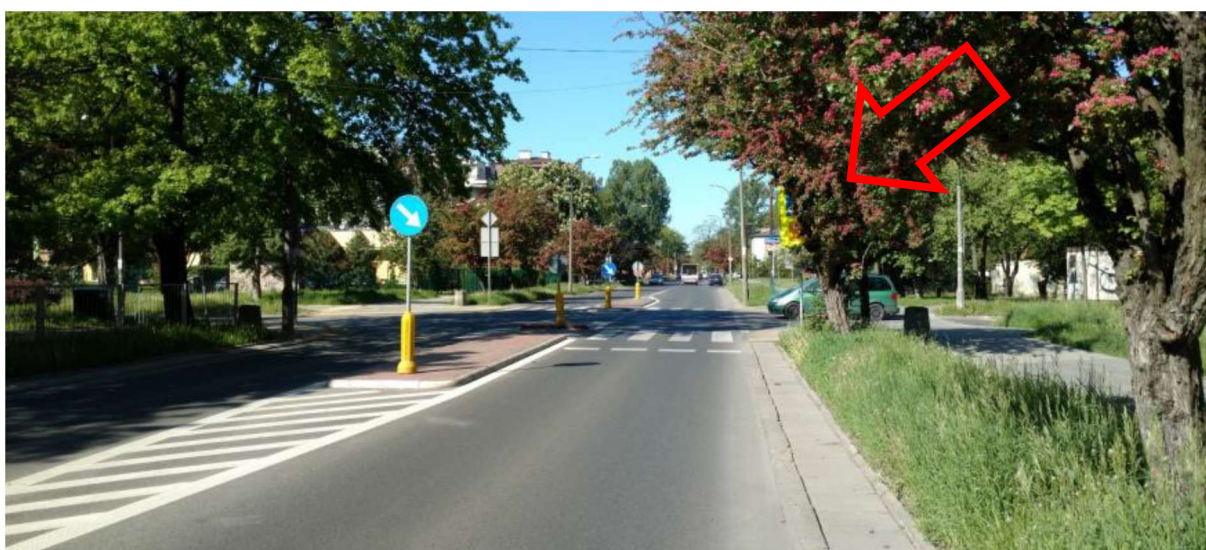
ZDJĘCIE 97 OZNAKOWANIE PRZEJŚCIA SZKOLNEGO ZASŁONIĘTE PRZEZ ZIELEŃ
