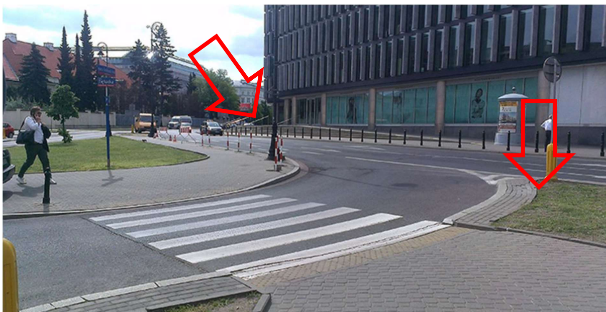
ZDJĘCIE 34 BRAK ZNAKÓW D-6 PRZED PRZEJŚCIEM DLA PIESZYCH
