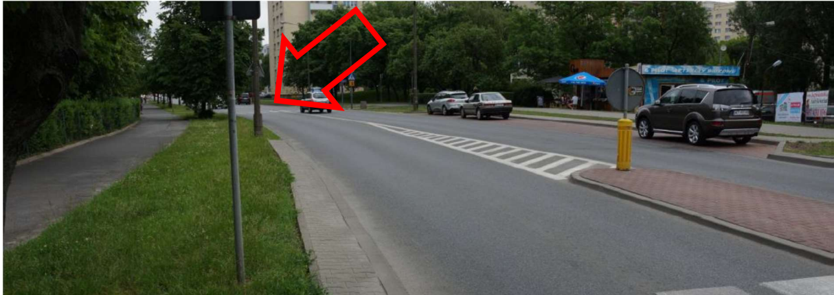
ZDJĘCIE 58 SZPALER DRZEW NA WEWNĘTRZNEJ KRAWĘDZI JEZDNI W ŁUKU POZIOMYM OGRANICZA WIDOCZNOŚĆ PIESZY-KIEROWCA
