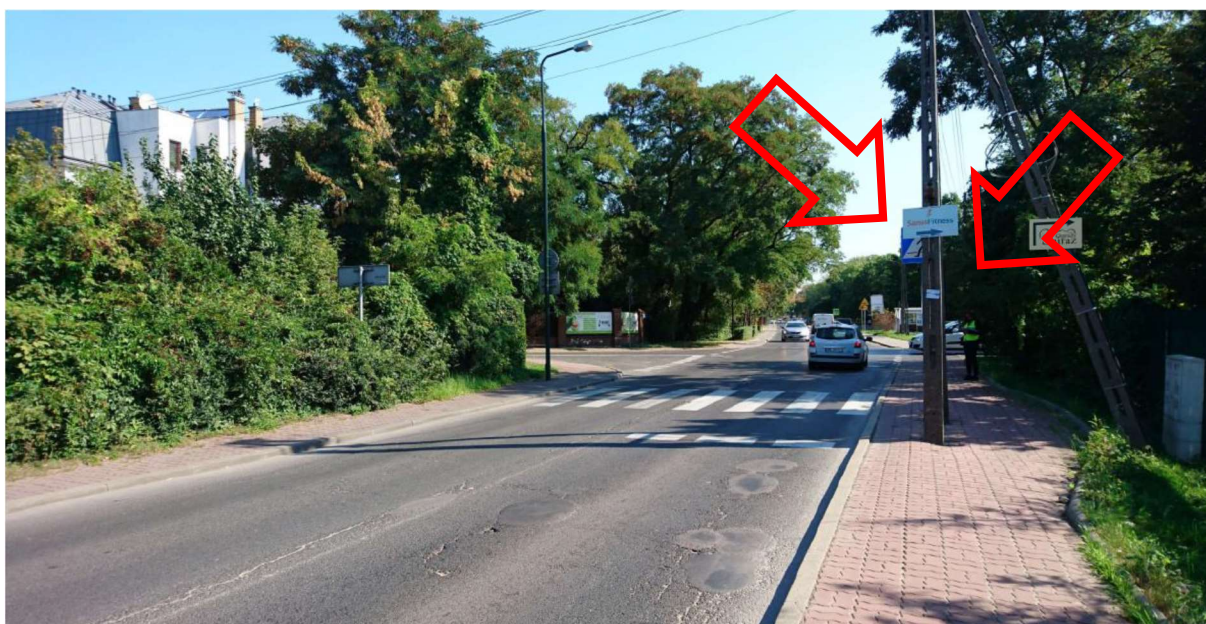
ZDJĘCIE 85 SŁUP ZASŁANIA PIESZEGO ZBLIŻAJĄCEGO SIĘ DO PRZEJŚCIA DLA PIESZYCH. ZASŁONIĘTE JEST TAKŻE OZNAKOWANIE PIONOWE
