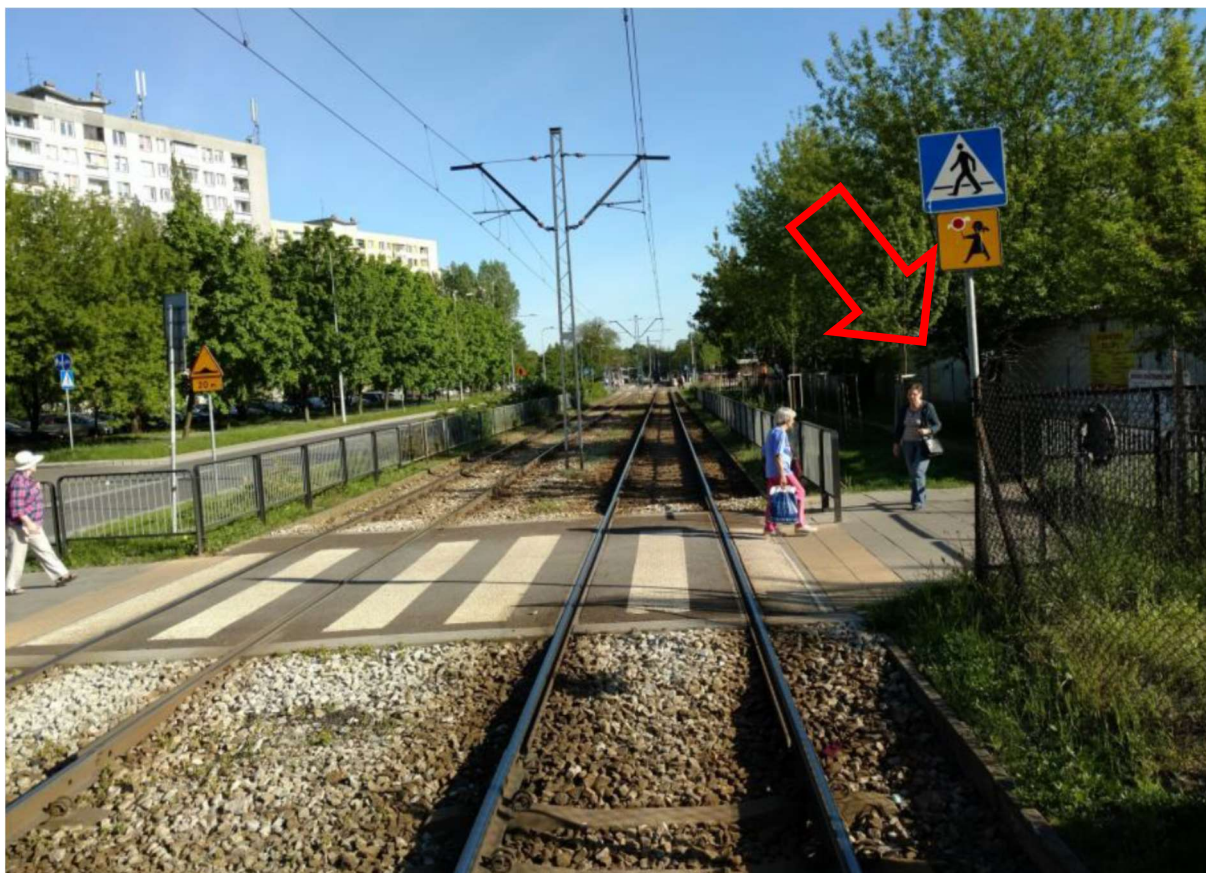
ZDJĘCIE 133 OGRODZENIE OGRANICZAJĄCE WIDOCZNOŚĆ NA PRZEJŚCIU DLA PIESZYCH PRZEZ TOROWISKO
