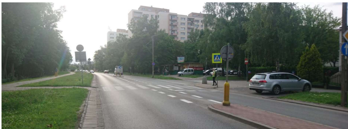
ZDJĘCIE 114 PRZEJŚCIE DLA PIESZYCH BEZ WYSPI AZYLU POMIĘDZY WSPAMI DZIELĄCYMI W KRAWĘŻNIKACH
