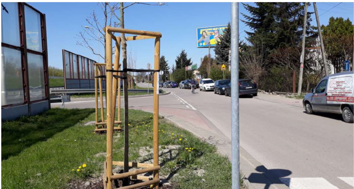
ZDJĘCIE 60 DRZEWA POSADZONE W TRÓJKĄCIE WIDOCZNOŚCI. DRZEWA ZASLANIAJĄ PIESZEGO DOCHODZĄCEGO DO PRZEJŚCIA DLA PIESZYCH KIEROWCY SKRĘCAJĄCEMU W PRAWO
