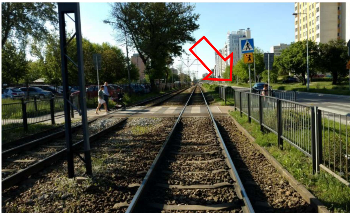
ZDJĘCIE 134 WYGRODZENIA ZASLANIAJĄCE PIESZEGO DOCHODZĄCEGO DO PRZEJŚCIA PRZEZ TOROWISKO
