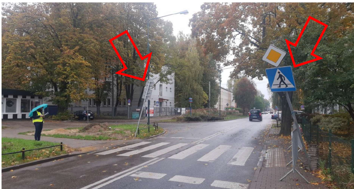
ZDJĘCIE 38 PRZEKRZYWIONE SŁUPKI ZNAKÓW PIONOWYCH
