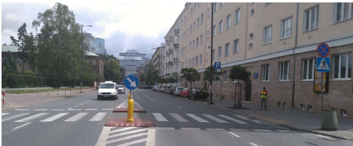
ZDJĘCIE 20 PRZEJŚCIE DLA PIESZYCH W OBSZARZE ZAGROŻENIA WYSOKĄ LUB BARDZO WYSOKĄ PRĘDKOŚCIĄ, WYZNACZONE PRZEZ DWA PASY RUCHU W JEDNYM KIERUNKU
