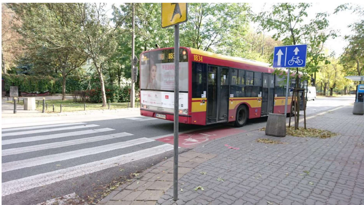
ZDJĘCIE 80 OGRANICZENIE WIDOCZNOŚCI NA PRZEJŚCIU DLA PIESZYCH SPOWODOWANE PRZEZ AUTOBUS OBECNY NA PRZYSTANKU
