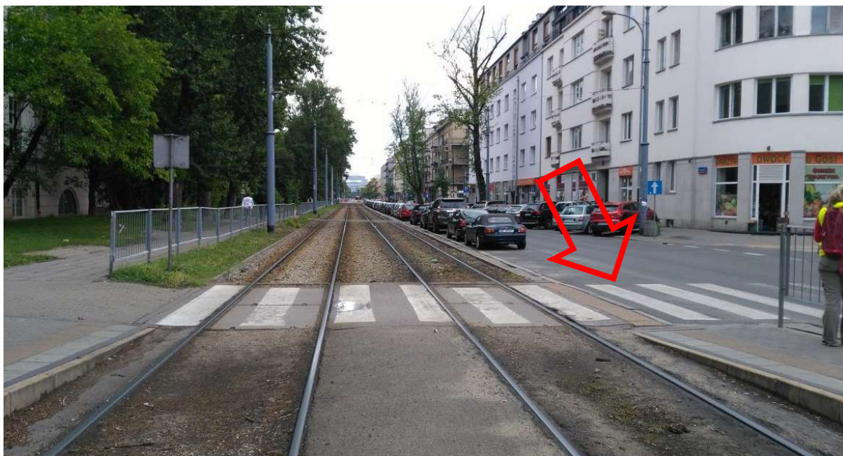
ZDJĘCIE 136 BRAK BEZPIECZNEJ STREFY ZATRZYMANIA PIESZEGO PRZED TOROWISKIEM
