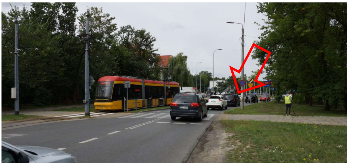
ZDJĘCIE 36 BRAK ZNAKU D-6 PRZED PRZEJŚCIEM DLA PIESZYCH
