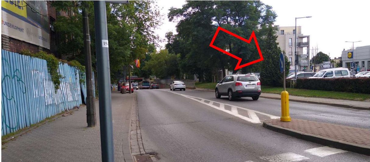
ZDJĘCIE 40 NIEWIDOCZNY, NIEPRAWIDŁOWO USTAWIONY ZNAK C-9
