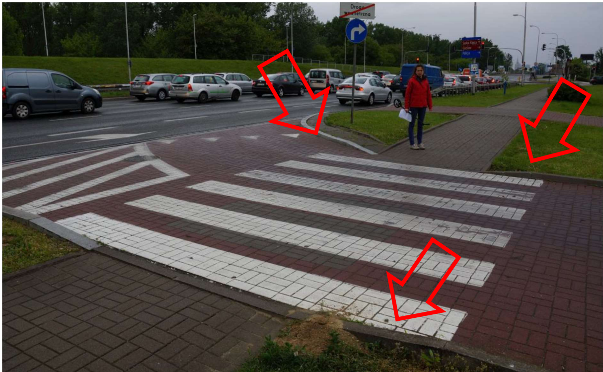
ZDJĘCIE 103 SKOSY KRAWĘŻNIKÓW – PRZESZKODY DLA PIESZYCH OPUSZCZAJĄCYCH PRZEJŚCIE DLA PIESZYCH
