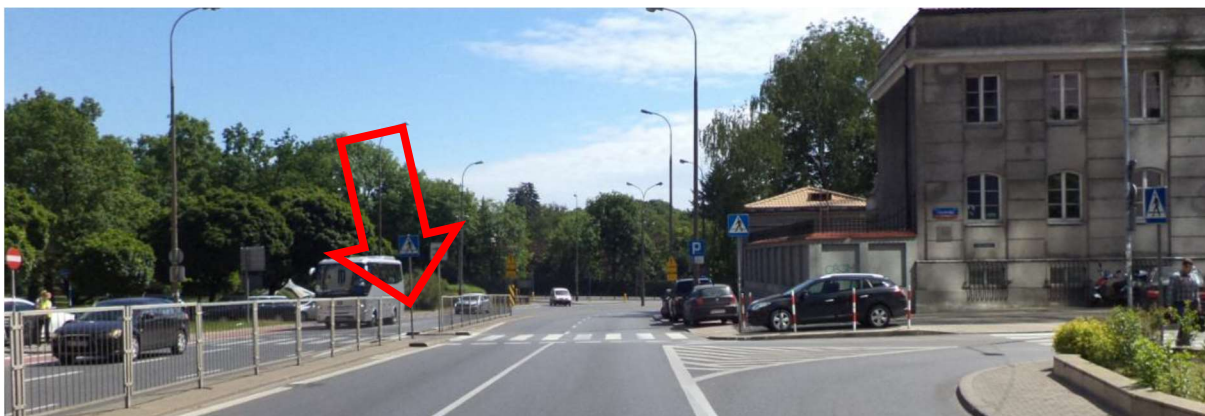
ZDJĘCIE 121 ZBYT WĄSKA WYSPA DZIELĄCA W OBRĘBIE PRZEJŚCIA DLA PIESZYCH
