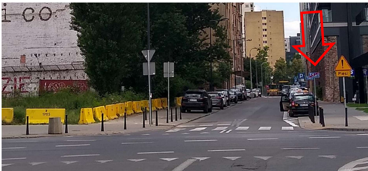
ZDJĘCIE 35 BRAK ZNAKU D-6 PRZED PRZEJŚCIEM OD STRONY TARCZY SKRZYŻOWANIA
