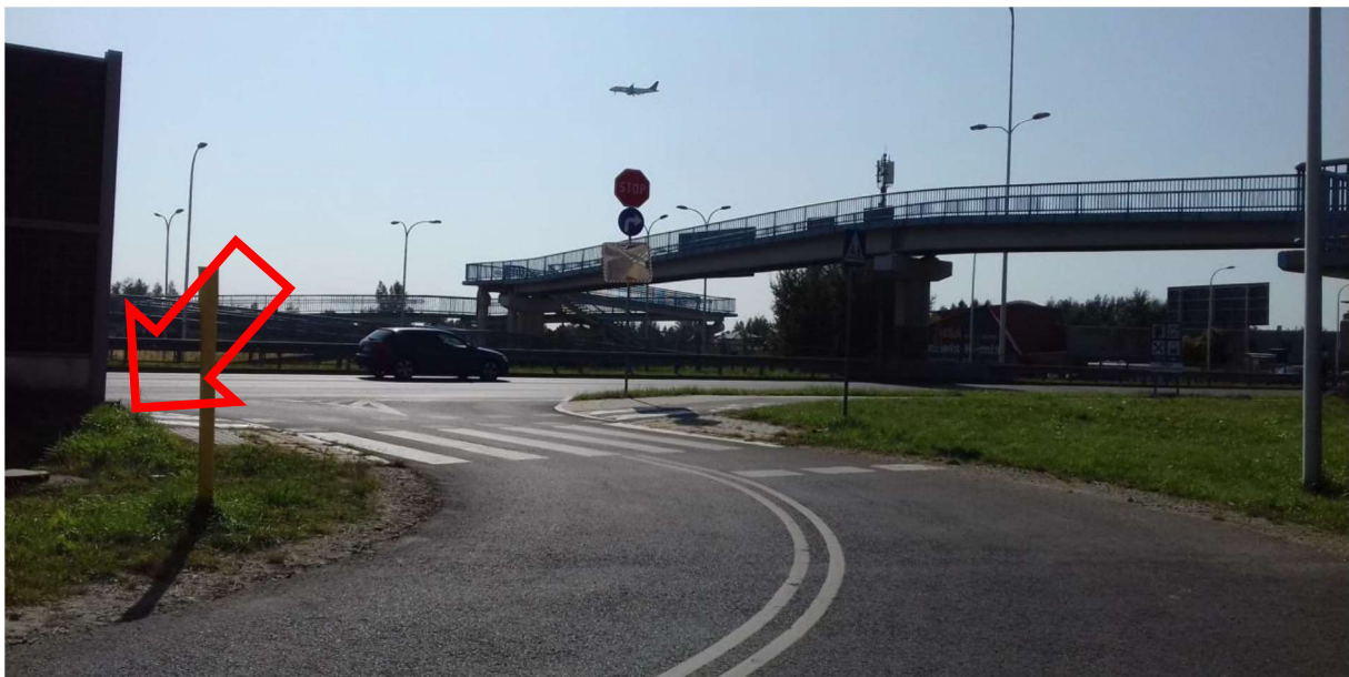
ZDJĘCIE 88 EKRAN AKUSTYCZNY OGRANICZA WIDOCZNOŚĆ. PIESZY WYCHODZI NA PRZEJŚCIE DLA PIESZYCH ZZA EKRANU. ROWERZYSTA WYJEŹDZA ZZA EKRANU NA PRZEJAZD ROWEROWY
