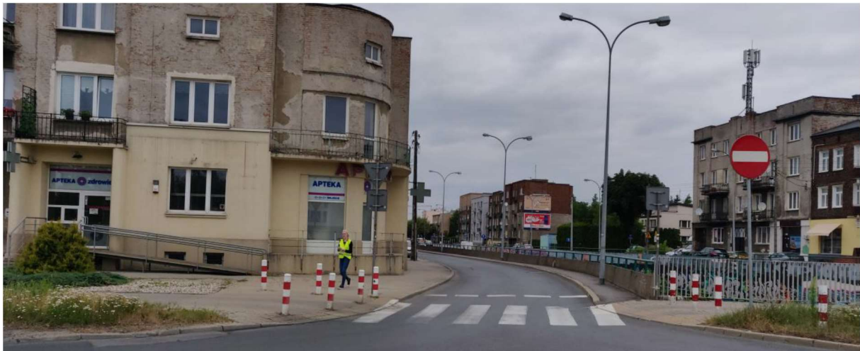
ZDJĘCIE 92 BUDYNEK OGRANICZA WIDOCZNOŚĆ
