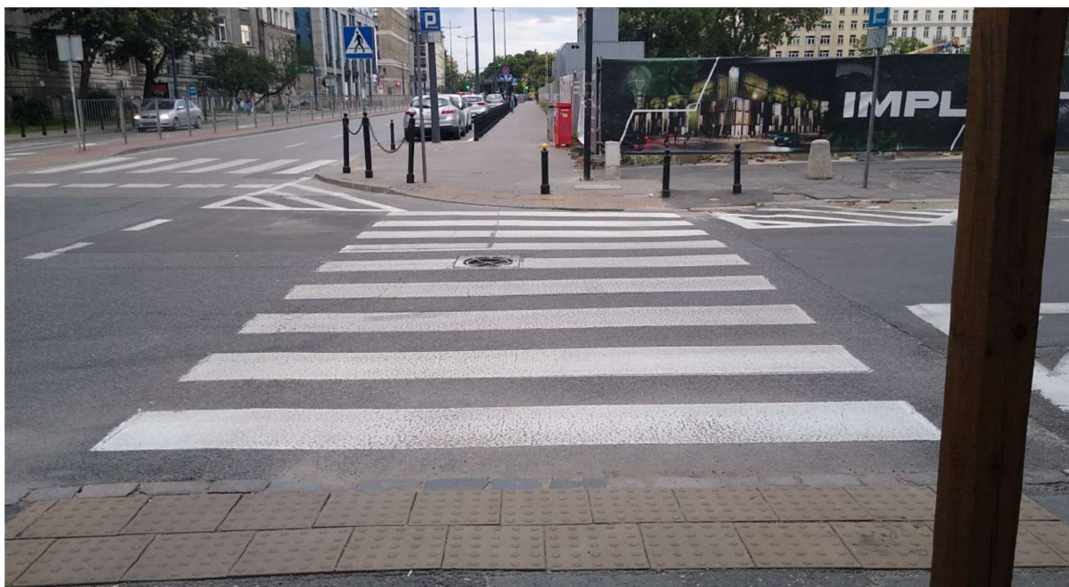
ZDJĘCIE 33 STUDZIENKA W OBSZARZE PRZEJŚCIA
