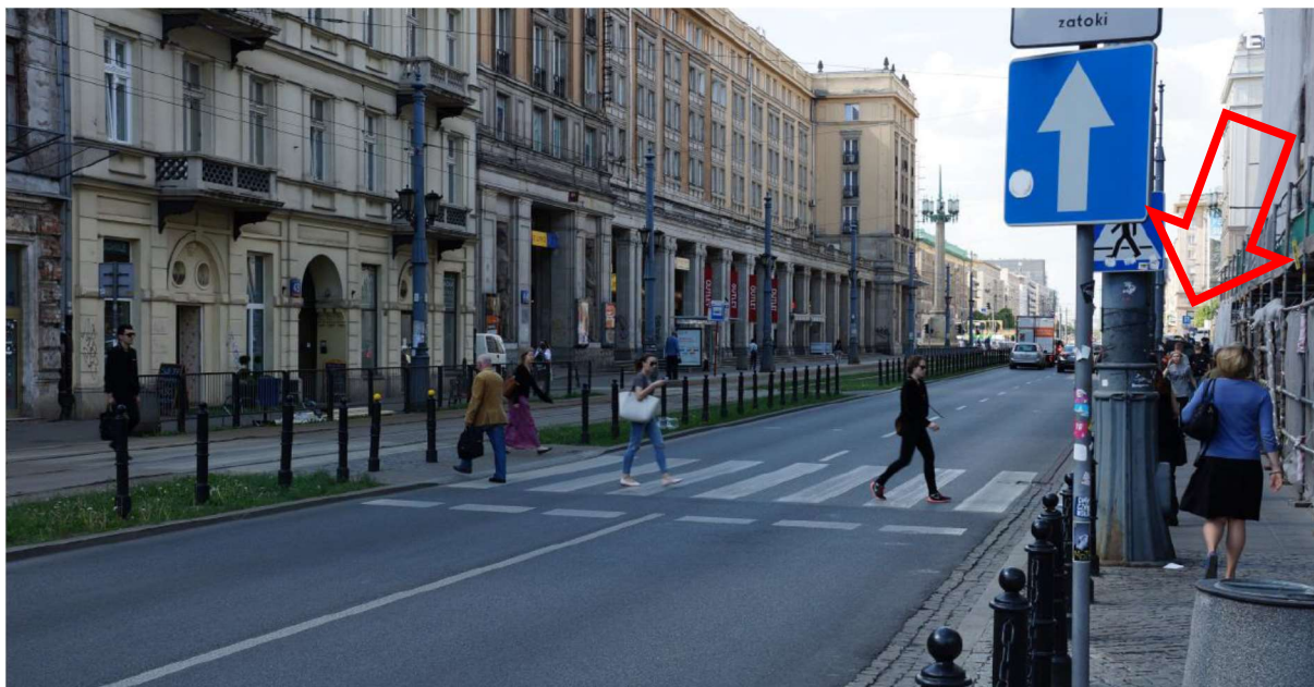
ZDJĘCIE 84 MASYWNY SŁUP ZASŁANIA PIESZEGO ZBLIŻAJĄCEGO SIĘ DO PRZEJŚCIA DLA PIESZYCH
