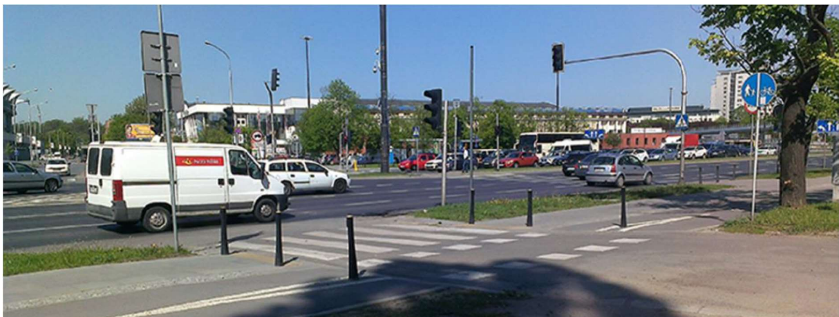
ZDJĘCIE 42 BRAK POWIERZCHNI AKUMULACJI PRZED PRZEJŚCIEM DLA PIESZYCH
