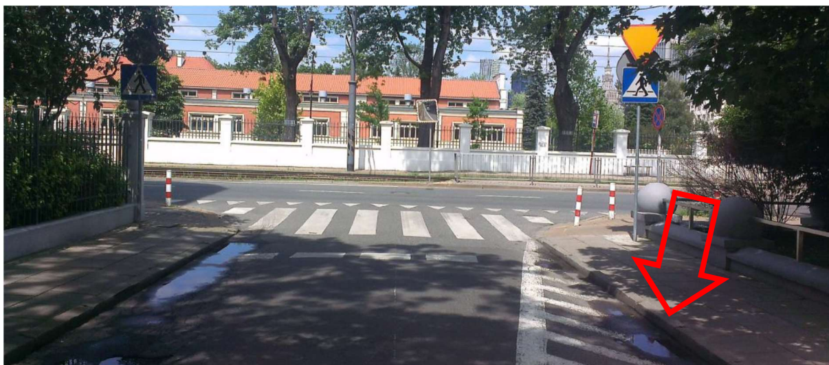
ZDJĘCIE 45 PRZEJŚCIE WRAŻLIWE NA ZASTAWIANIE I OGRANICZENIA WIDOCZNOŚCI. ŚLADY PARKUJĄCYCH POJAZDÓW I WODA GROMADZĄCA SIĘ W ZAGŁĘBIENIACH.
