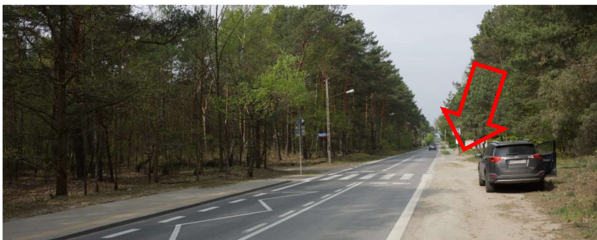
ZDJĘCIE 37 BRAK ZNAKU D-6 PRZED PRZEJŚCIEM DLA PIESZYCH
