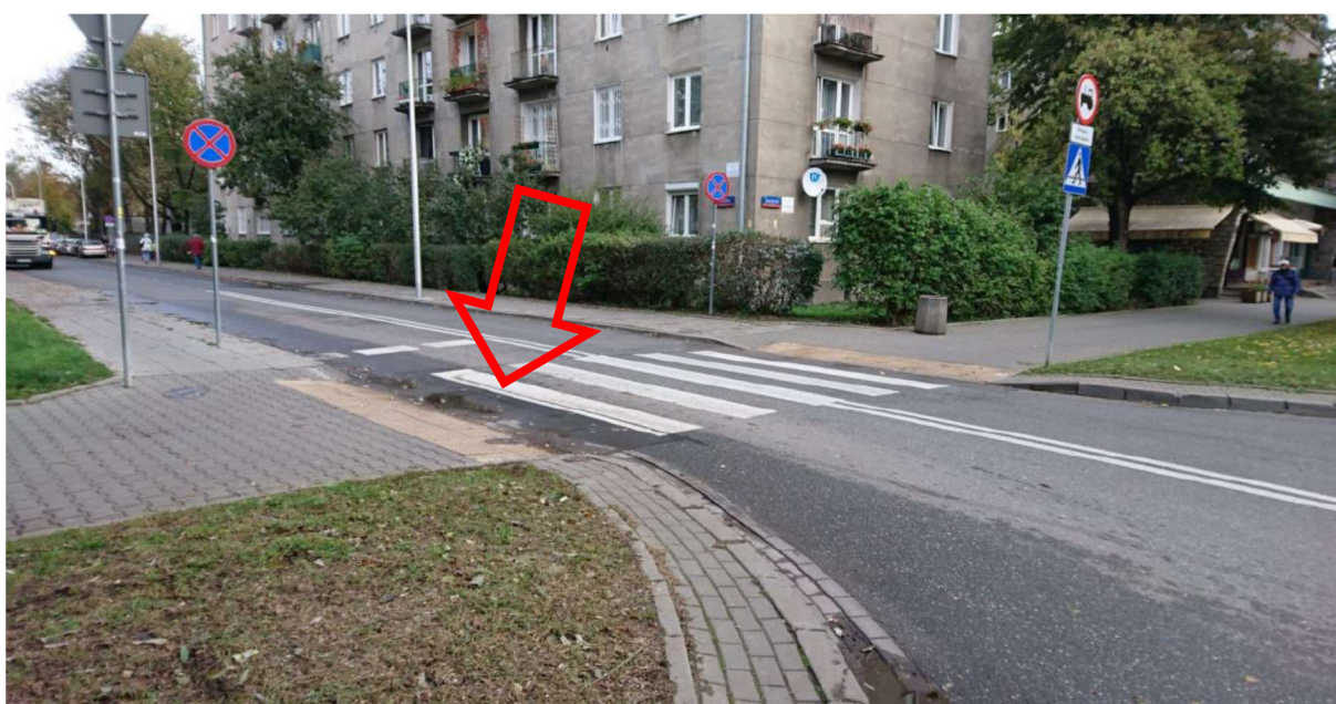
ZDJĘCIE 25 NAJNIŻSZY PUNKT ZLEWNI W OBSZARZE PRZEJŚCIA DLA PIESZYCH, ŚLADY GROMADZĄCEJ SIĘ WODY
