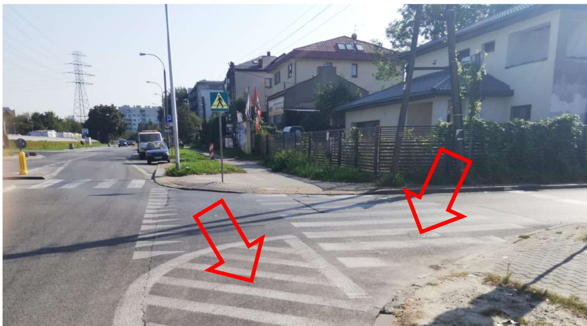
ZDJĘCIE 66 POWIERZCHNIA WYŁĄCZONA Z RUCHU OZNAKOWANIA LINIĄ P-21 NIE ZABEZPIECZA PIESZYCH NA KRAWĘDZI PRZEJŚCIA. POJAZD SKRĘCAJĄCY W LEWO Z WLOTU PODPORZĄDKOWANEGO NAJEŹDŹA NA KRAWĘDŹ PRZEJŚCIA.
