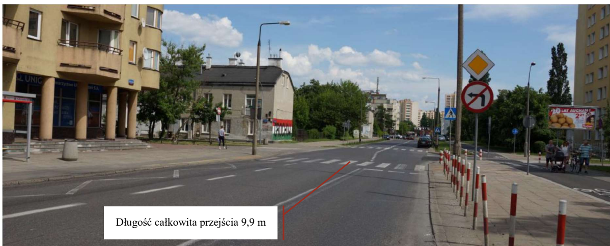
ZDJĘCIE 14 ZBYT DŁUGIE PRZEJŚCIE DLA PIESZYCH NA DRODZE Z PIERWSZEŃSTWEM PRZEJAZDU
