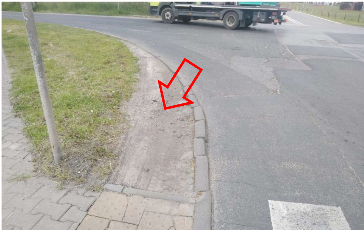
ZDJĘCIE 64 ŚLADY NAJAZDU POJAZDÓW NA KRAWĘDZ PRZEJŚCIA DLA PIESZYCH. ZNISZCZONY PAS PŁYTEK OSTRZEGAWCZYCH
