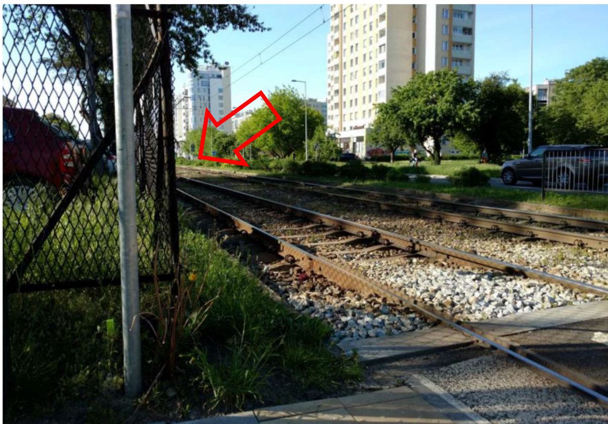
ZDJĘCIE 132 OGRODZENIE OGRANICZAJĄCE WIDOCZNOŚĆ NA PRZEJŚCIU DLA PIESZYCH PRZEZ TOROWISKO
