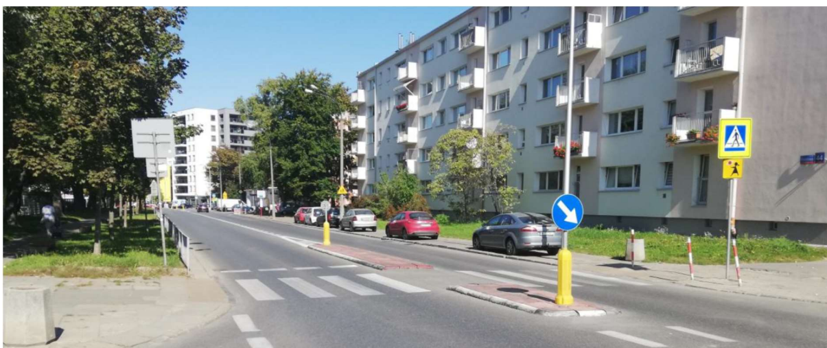
ZDJĘCIE 122 ZBYT WĄSKA WYSPA AZYLU DLA PIESZYCH NA PRZEJŚCIU W POBLIŻU SZKOŁY, UCZĘSZCZANYM PRZEZ DZIECI
