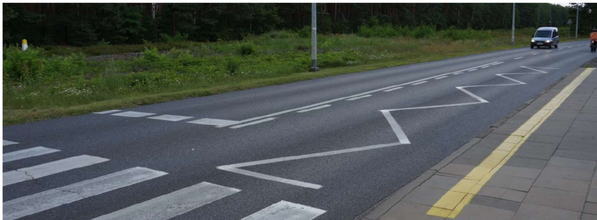
ZDJĘCIE 78 PRZYSTANEK AUTOBUSOWY TUŻ ZA PRZEJŚCIEM - ODLEGŁOŚĆ WIDOCZNOŚCI PIESZY-KIEROWCA PODCZAS OBECNOŚCI AUTOBUSU NA PRZYSTANKU WYNOŚI 0 M
