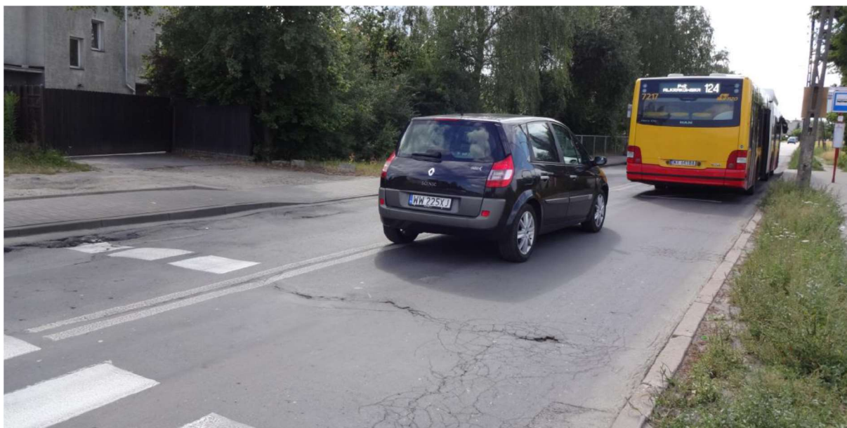
ZDJĘCIE 79 OGRANICZENIE WIDOCZNOŚCI NA PRZEJŚCIU DLA PIESZYCH SPOWODOWANE PRZEZ AUTOBUS OBECNY NA PRZYSTANKU
